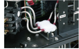
Conexiones eléctricas recubiertas
